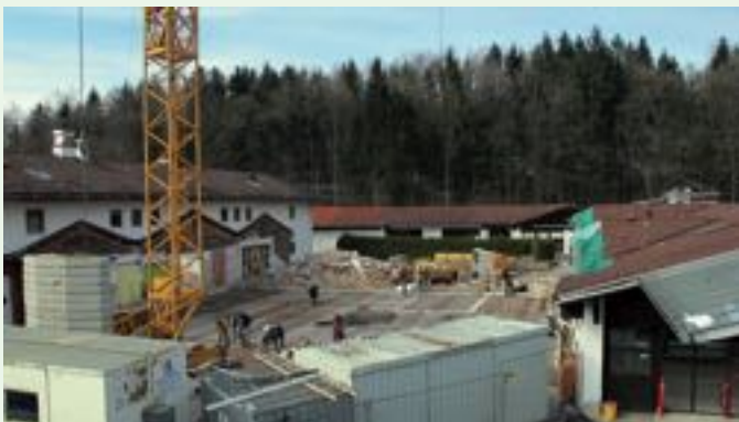
März 2018 - Die neue Bodenplatte wurde befestigt.
