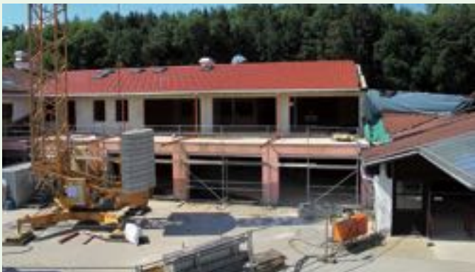
Juli 2018 - Das Dach wurde gedeckt.
