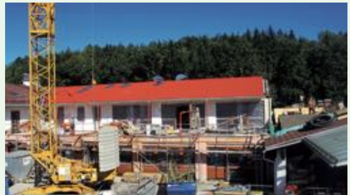
August 2018 - Die Fenster und Türen wurden montiert. Der Innenausbau hat begonnen
