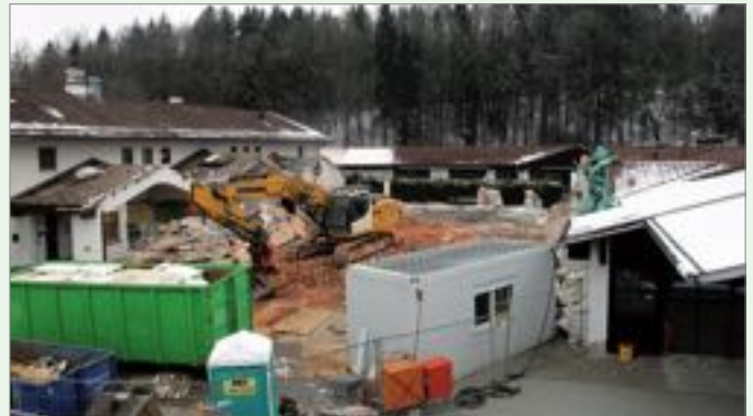
Februar 2018 - Das alte Gebäude wurde abgerissen.
