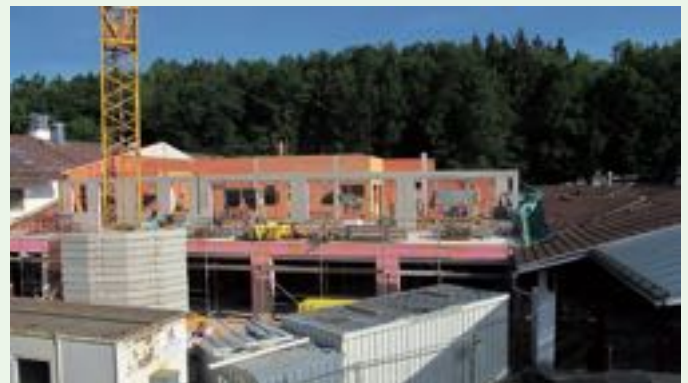
Mai 2018 - Die Wände wurden gemauert.
